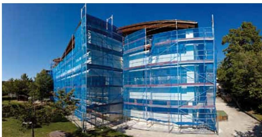
Entrambi i lotti sono stati fissati nei mesi estivi del 2011 e 2012 e hanno previsto il rinnovamento di pavimenti e finestre esterne, la sostituzione di tutte le porte, l'installazione degli impianti e il risanamento energetico della facciata. Nel 2012 è, invece, in programma la ristrutturazione della palestra. Tutti questi interventi renderanno quest'immobile di tre piani, realizzato negli anni '80, più moderno e adeguato ai moderni standard.
