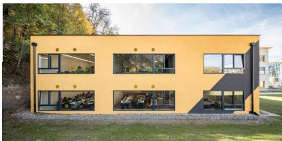
calcestruzzo. Il basamento ha consentito il montaggio di un involucro energetico prefabbricato sull'intero edificio. Tutta la scuola è stata, per così dire, rivestita a nuovo. I componenti prefabbricati in legno utilizzati allo scopo, alti 12 metri e larghi 3, per un totale di 360 metri lineari e una superficie di oltre 3.000 metri quadrati, sono stati sollevati con una gru, adattati ai vecchi muri esterni e immediatamente montati.
