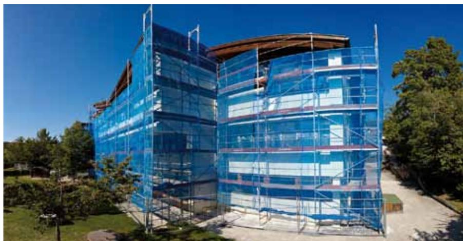
Die beiden Baulose wurden in die Sommermonate 2011 und 2012 gelegt. Dabei wurden 2011 die Bodenbeläge erneuert, alle Türen ausgetauscht, einige Installationsarbeiten vorgenommen. Die Außenfenster wurden erneuert sowie die Fassade energetisch gut saniert. Für 2012 ist nun der Umbau der Turnhalle vorgesehen. Damit und mit den getätigten Maßnahmen, wird das Gebäude, das in den 80er Jahren mit seinen drei Etagen entstand, modernisiert und auf einen neuen Standard gebracht.
